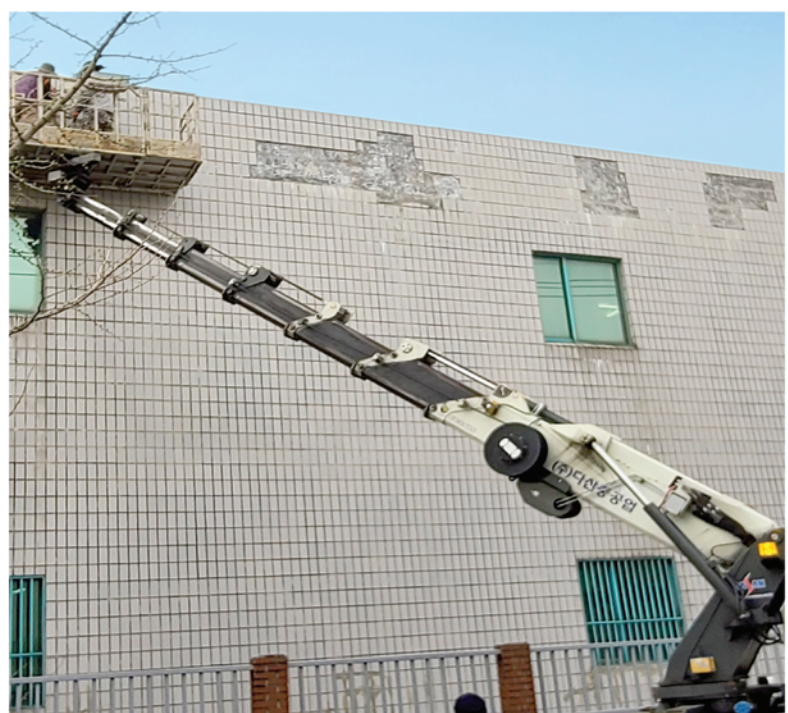
뒷면 벽체 타일 보수
